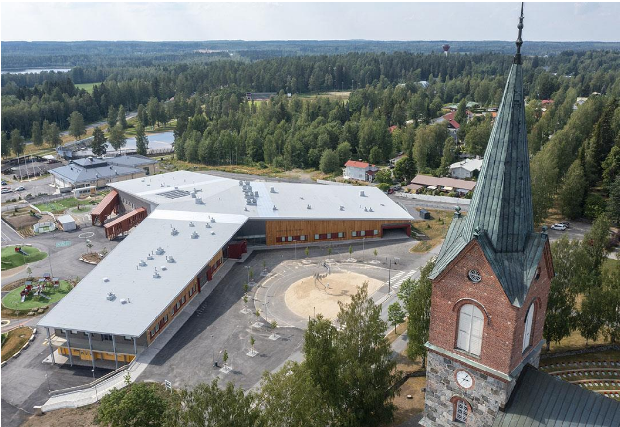
Martti Talvela -campus, Juva, 8400 brm2, uudisrakennus. valmistunut 2021
